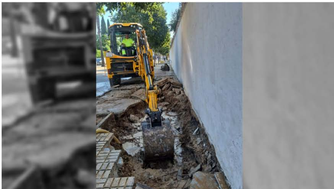
Una excavadora trabajando en el lugar de la rotura de la tubería.
