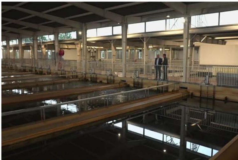
Pour sécuriser la qualité et l'approvisionnement en eau potable : la station des eaux est en pleine rénovation, le 22 octobre 2024, à Limoges.
